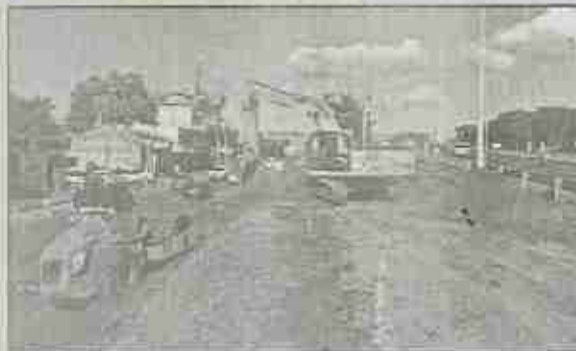
Las tareas se incrementaron en la vía de acceso ubicada entre la avenida San Blas y la ruta 7, a unos 300 metros del viaducto.
