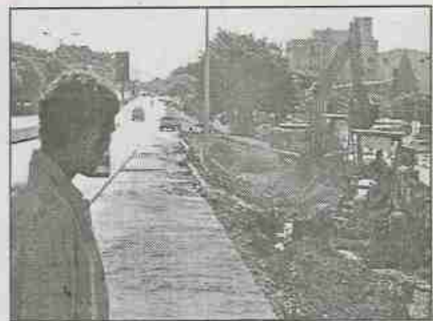
Un obrero observa cómo maquinarias pesadas trabajan intensamente en la zona del Km 4.
